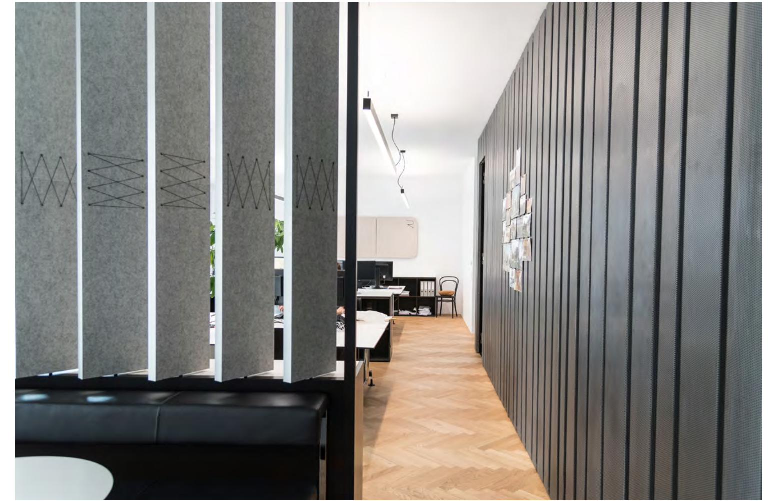
Lamellen aus Schafwollpaneelen / Projekt Roeck Architekten Büro Innsbruck, Pin Design by Roeck Architekten
